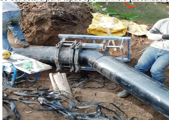
Termofusión [Localización:K0+090]
