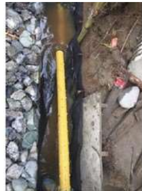
Instalacion de tuberia y conformacion de filtro detrás del gavion 2 del muro #2
