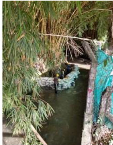
Desvio de quebrada para paso sub fluvial
