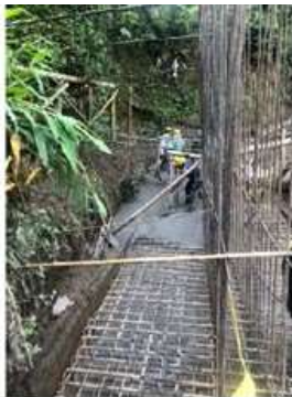
Vaciado de concreto tramo 3 zarta 2 muro #2
