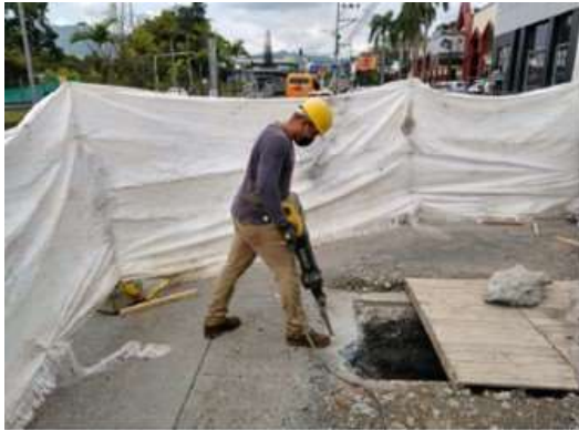
Demolicion de via para construccion de cámara de aguas lluvias
