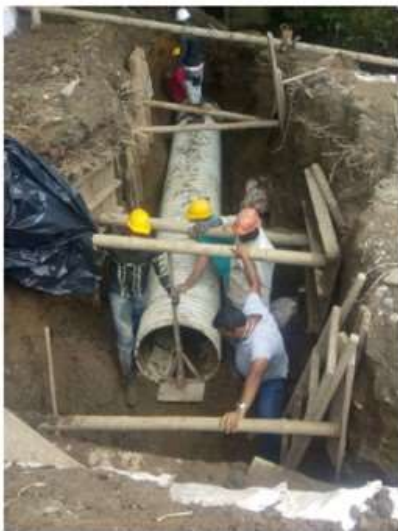
Instalación de tubería para descole
