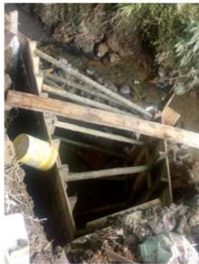
Construcción cabezal de descole
