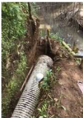
Instalacion tuberia tipo novafort de 30"
