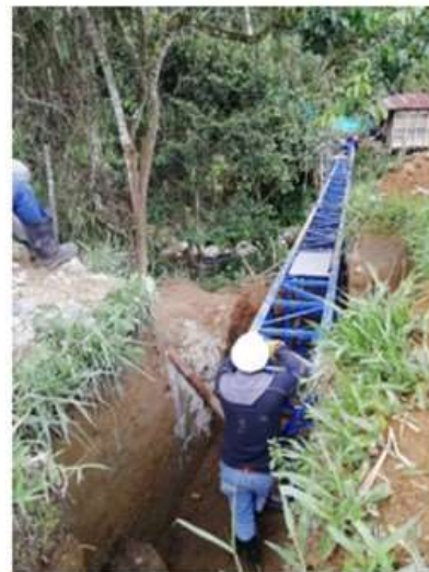
Instalación Viaducto numero 4
