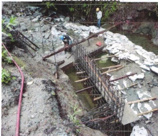
*Armado de hierro de zapata en bocatoma [Localización:K0+000]*
