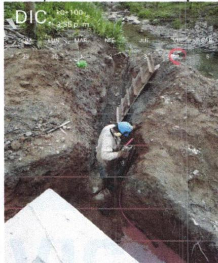
Demolición de roca en descarga del desarenador [Localización:K0+110]
