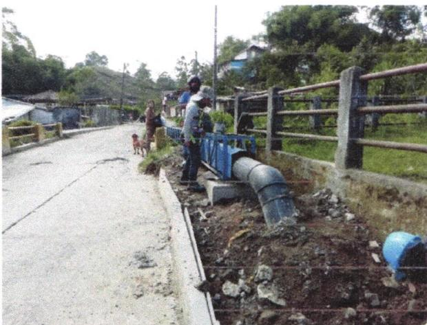
Proceso de instalcion de Proteccion para Tuberia en viaducto
