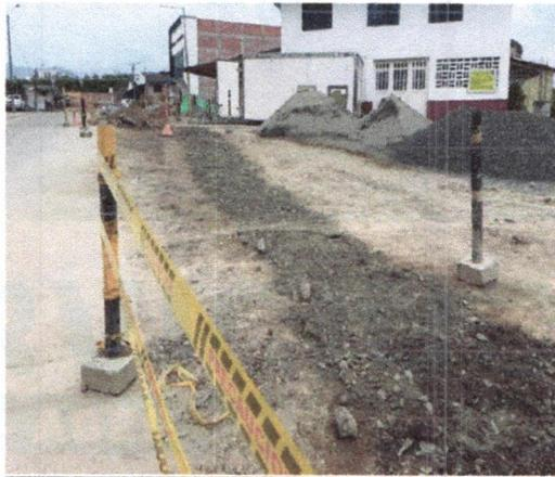
**PROCESO DE LLENO CON MATERIAL SELECCIONADO DE LAS EXCAVACIONES EXPASIÓN ZONA LA BADEA**
