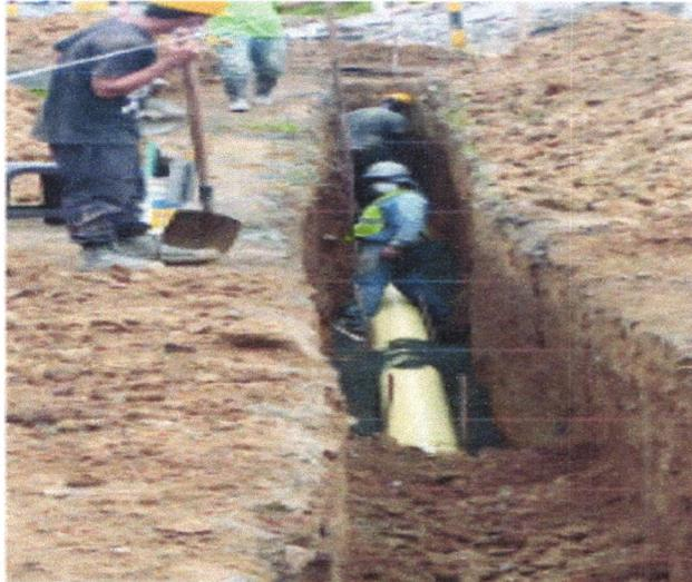
**PROCESO DE EXCAVACIÓN E INSTALACIÓN TUBERÍA PVC 10" EXPASIÓN ZONA LA BADEA**
