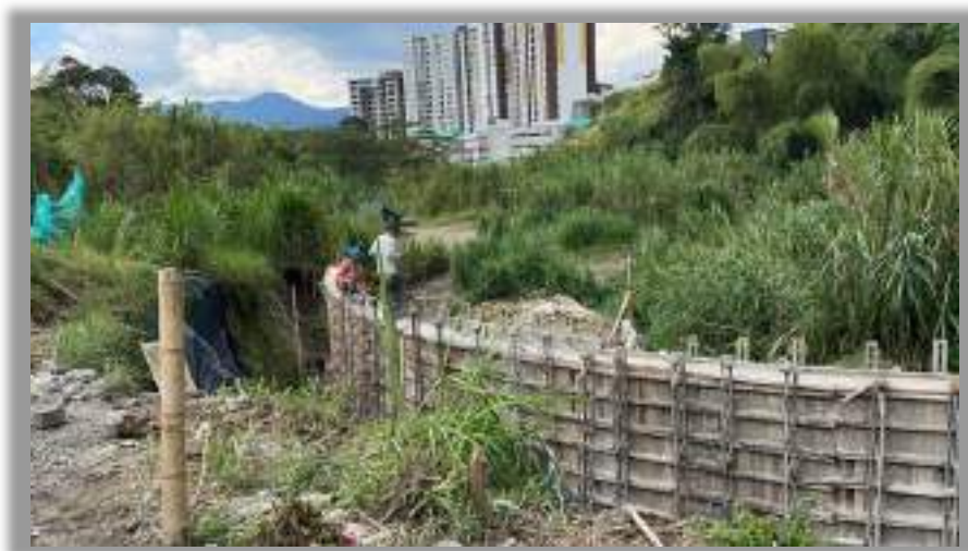
Muro en concreto reforzado
