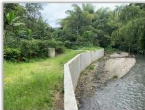
Muro y cámara inspección Interceptor Frailes
