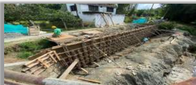
Proceso de encofrado para vaciado del muro de contención
