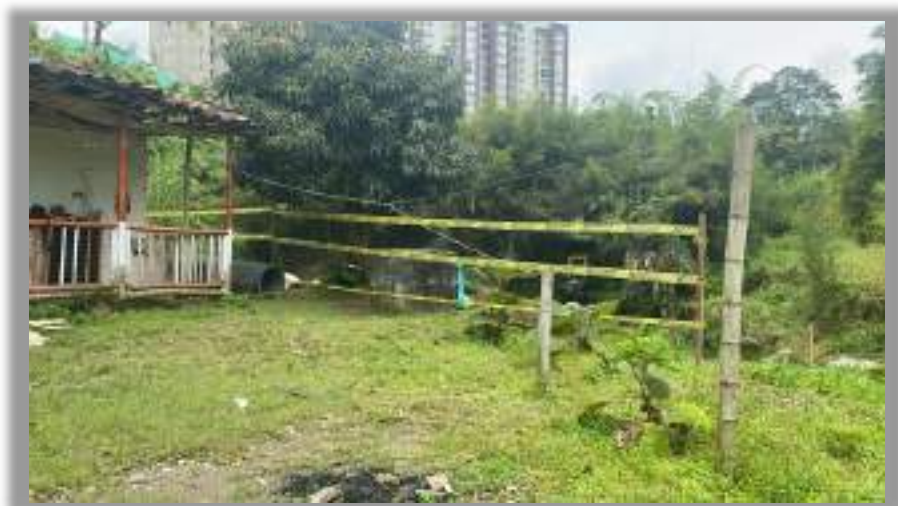
Se observa localización de viaducto a reconstruir
