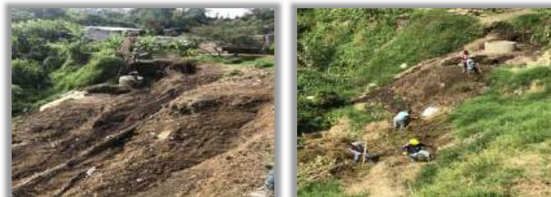
Perfilada Manual de Taludes
