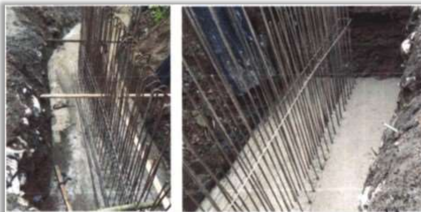
Zapata Muro y refuerzo Vástago
