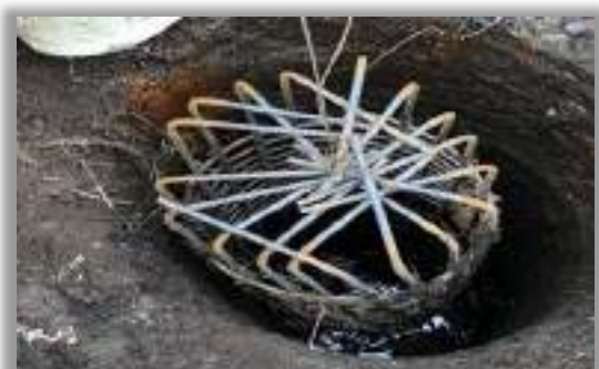
Refuerzo de caissons de un metro de diámetro – cimentación profunda
