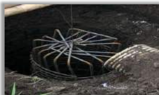
Refuerzo de caissons de un metro de diámetro – cimentación profunda
