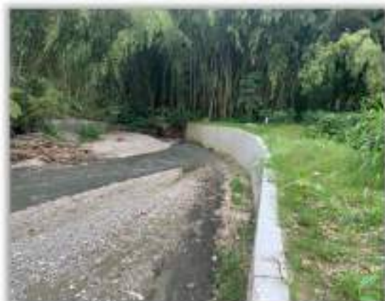
Muro en Concreto Reforzado
