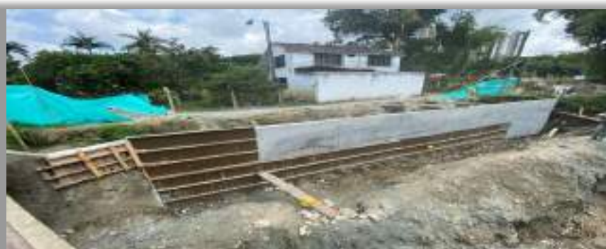
Desencofrado del Muro de contención en concreto
