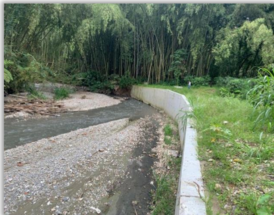
Muro en Concreto Reforzado
