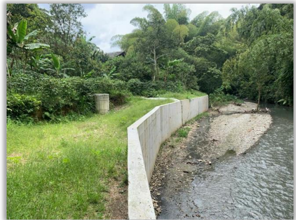
Muro y cámara inspección Interceptor Frailes
