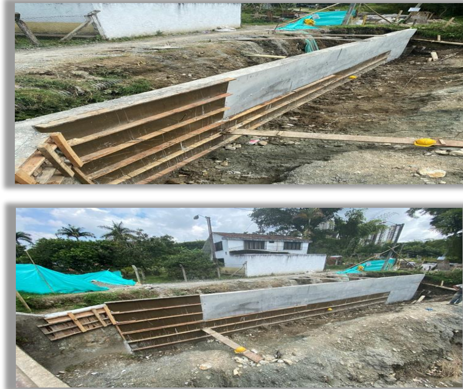
Desencofrado del Muro de contención en concreto
