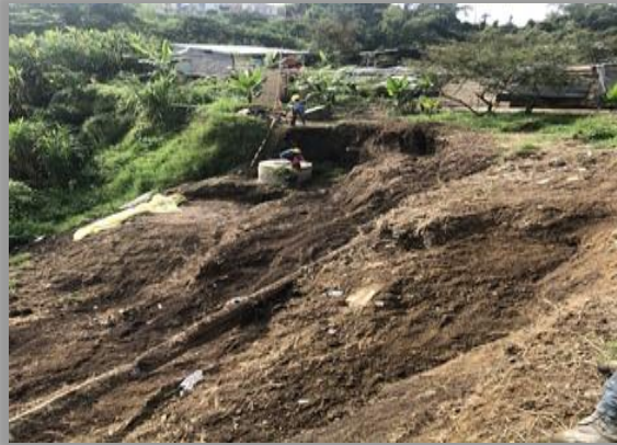
Perfilada Manual de Taludes
