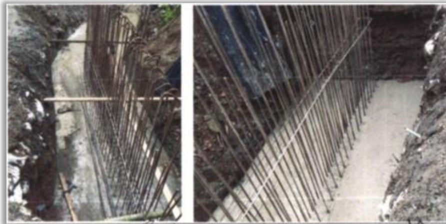
Zapata Muro y refuerzo Vástago
