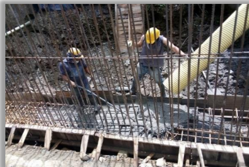
Vaciado de Concreto para cimentación profunda y zarpa muro de contención
