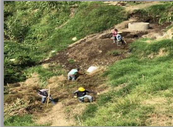
Perfilada Manual de Taludes
