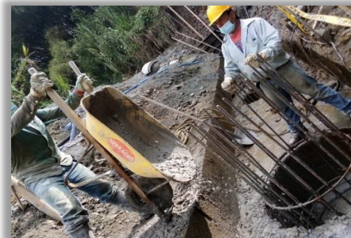
Vaciado de Concreto para cimentación profunda y zarpa muro de contención
