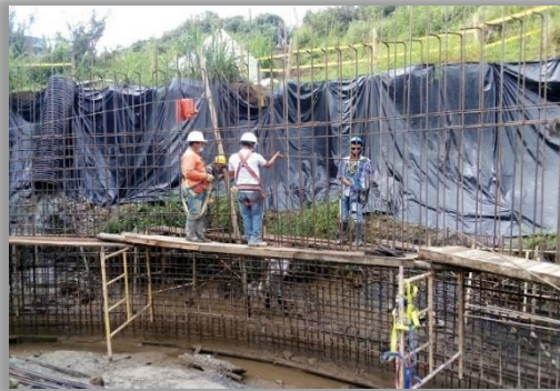
Corte y figurado de refuerzo para el muro de contención
