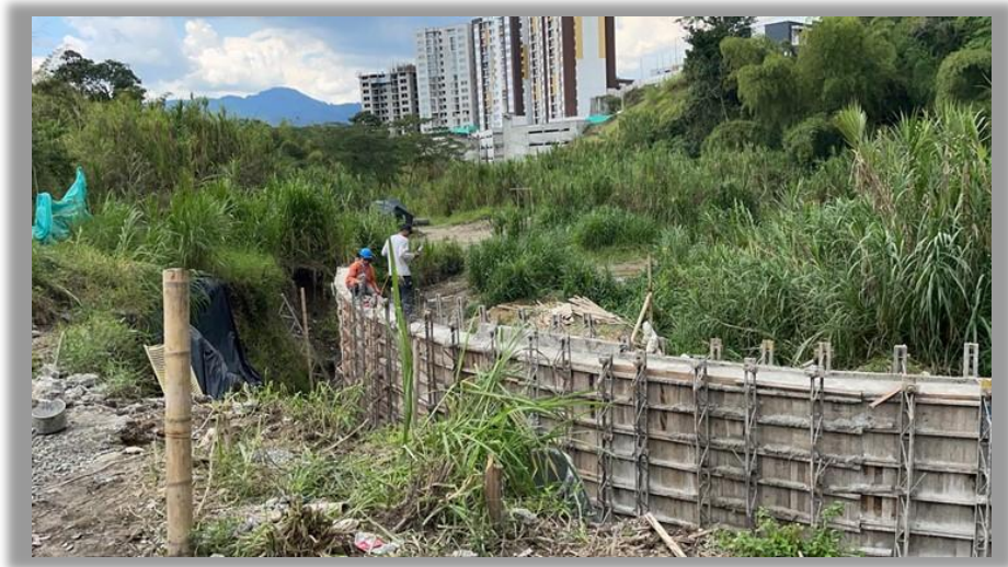
Muro en concreto reforzado
