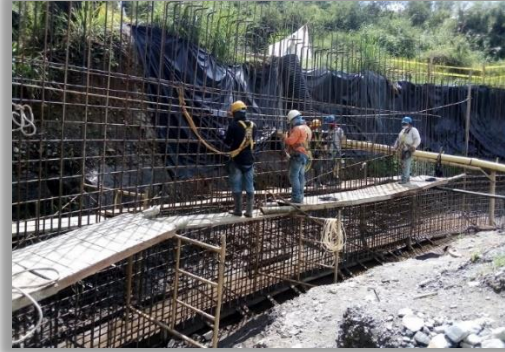
Corte y figurado de refuerzo para el muro de contención
