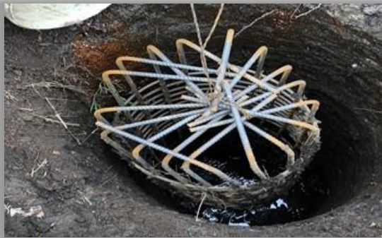
Refuerzo de caissons de un metro de diámetro – cimentación profunda
