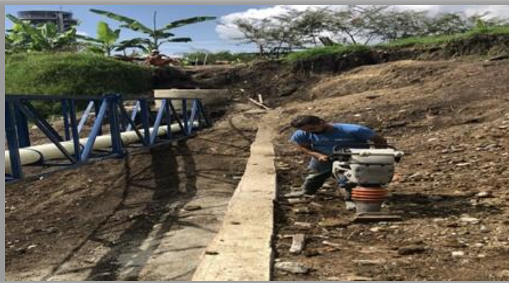
Perfilada Manual de Taludes
