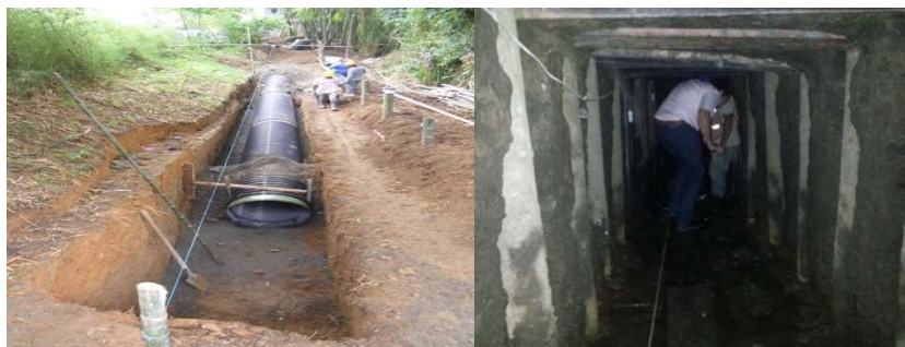
Imagen 12. Construcción interceptor Cañaveral
