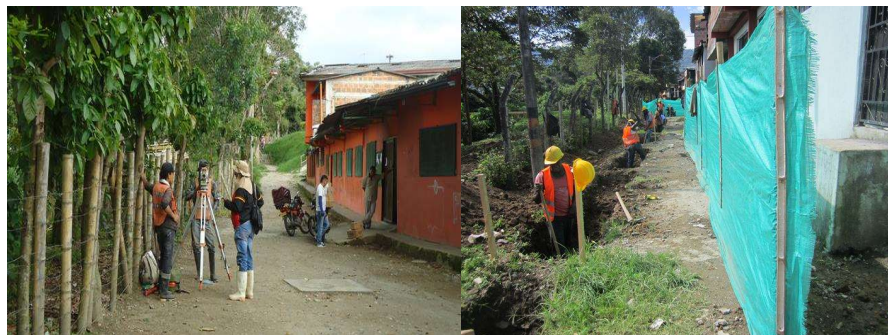
Imagen 13. Trazado y excavación interceptor Molinos
