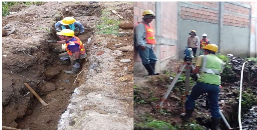
Imagen 16. Construcción interceptor Gutiérrez
