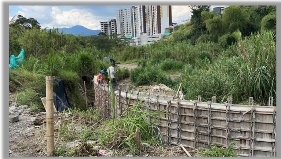
Muro en concreto reforzado
