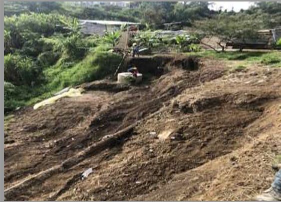
Perfilada Manual de Taludes
