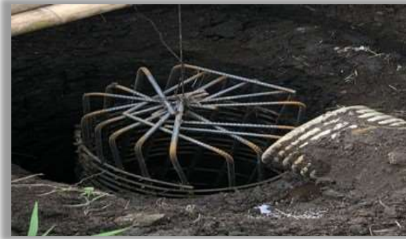
Refuerzo de caissons de un metro de diámetro – cimentación profunda
