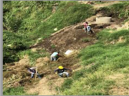
Perfilada Manual de Taludes
