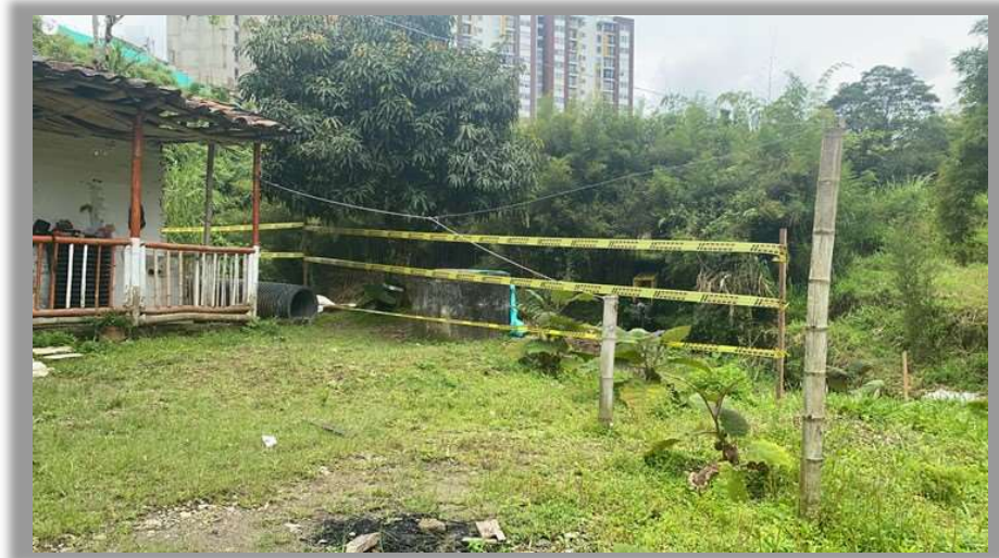
Se observa localización de viaducto a reconstruir
