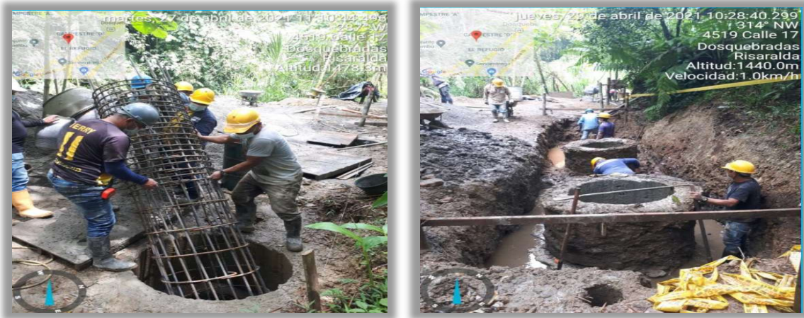
Acero de refuerzo para caisson Excavación en conglomerado zapata del muro
